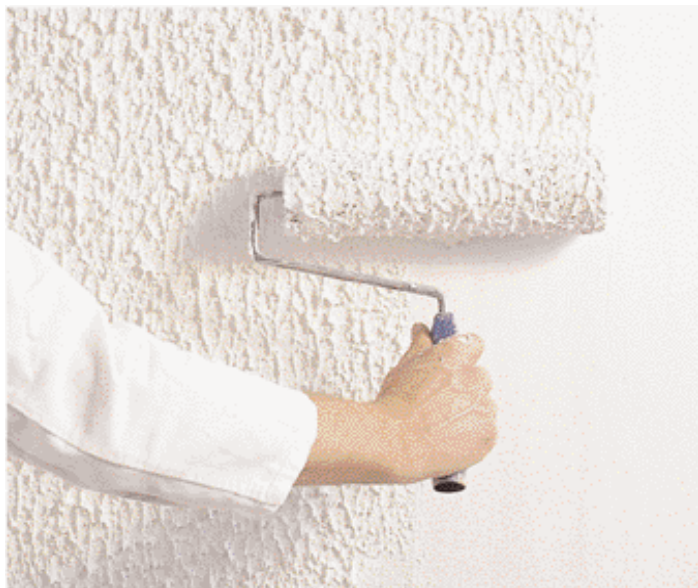
Aplicarea Capa-Rollputz cu rola din burete cu găuri.
