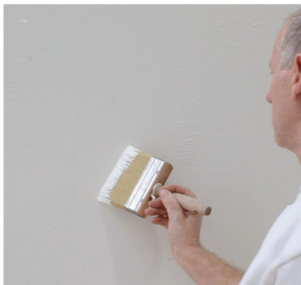
Stratul intermediar se aplică cu rola și se periază pentru uniformizare.
