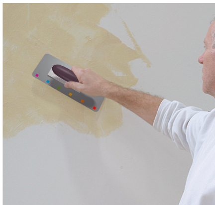
Petele de material se omogenizează pe suprafață...
