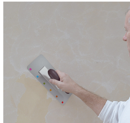
După uscarea primului strat se aplică ArteTwin Effect Gold sau Silber sub formă de pete sau pe întreaga suprafață prin aceeași tehnică de șpăcluire.
