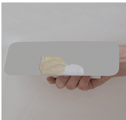
Materialul se așează alăturat pe gletiera specială pentru ArteTwin.
