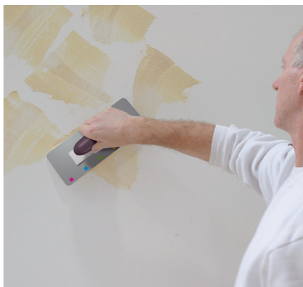
Materialul se aplică sub formă de pete alăturate pe stratul suport pe direcții diferite.
