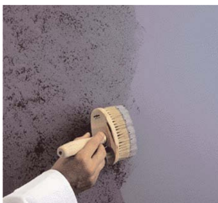
Arte-Lasur Color este gata preparat pentru aplicare. Se aplică 1 strat de lazură pe întreaga suprafață în mișcări scurte,
